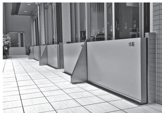
内部アルミハニカム・外面アルミ板止水板
