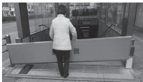
側枠内へ落とし込む (設置完了)
